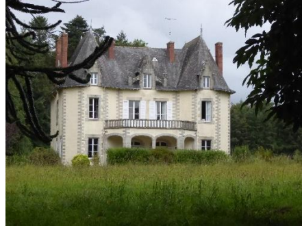
Villa de Kerlegan
