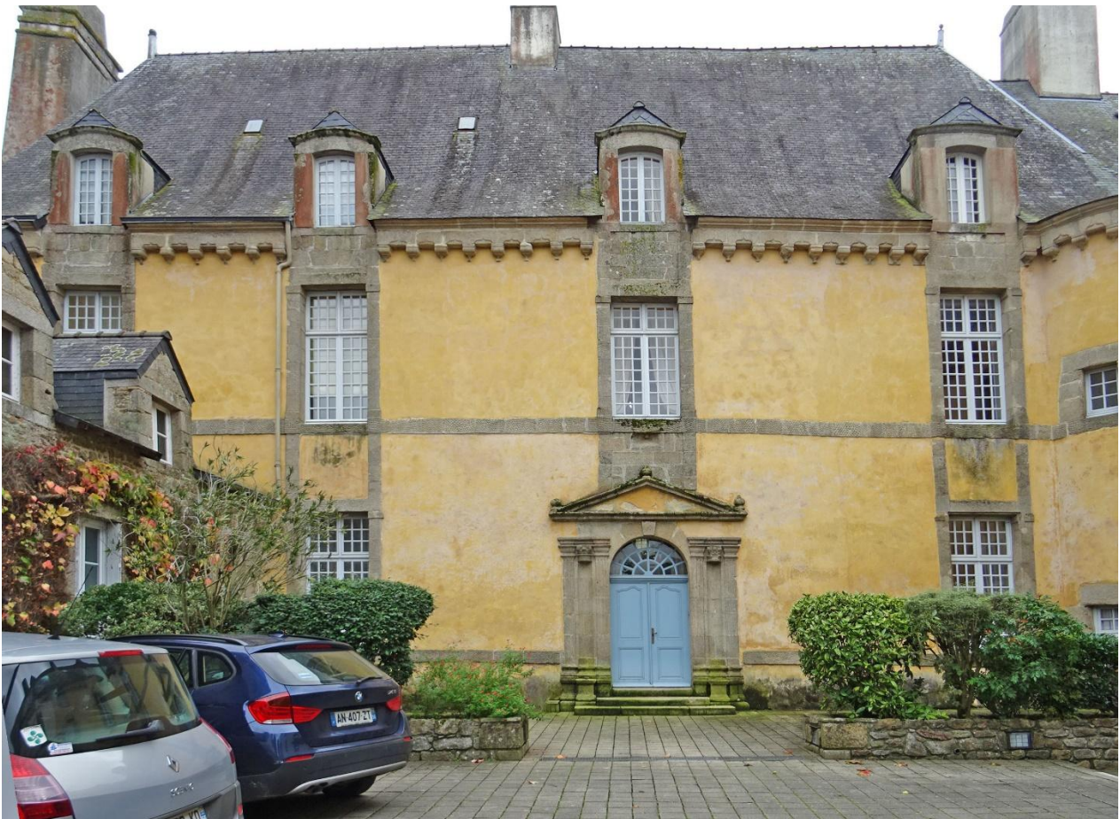
Exemple d'enduit de qualité : appliqué de manière pelliculaire, sans épaisseurs, sans boursoffures et de ton clair ici coloré en harmonie avec la pierre, parce que la demeure se situe en milieu urbain classique.
