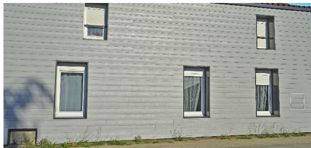
La même maison, après isolation par l'extérieur
