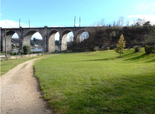
Viaduc du chemin de fer
