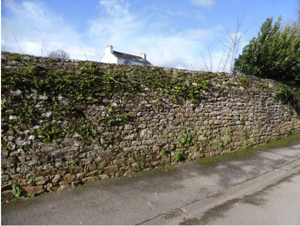
Mur d'enclos ou de clôture en pierres moellonnées. Celles-ci sont posées par assises et peuvent rester apparentes
