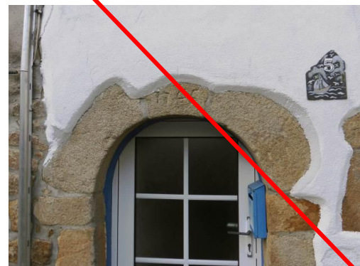
Ci-dessus, l'enduit a été appliqué en épaisseur et présente un fort relief par rapport au nu de la pierre apparente
