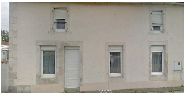
Une maison de pierre et d'enduit, avec ses encadrements de baies en pierre massive taillée
