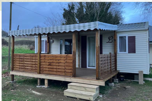
Mobil home en cours d'installation
