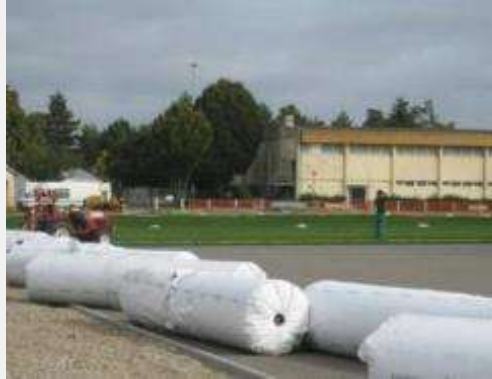
Réalisation du fin réglage de la plateforme et livraison des rouleaux de gazon synthétique
