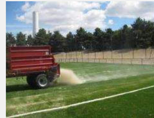
Remplissage du revêtement, en sable
