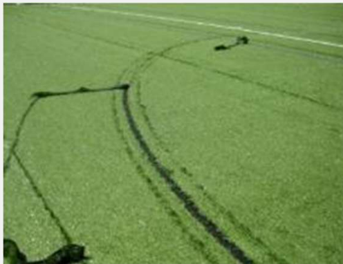
Découpage du revêtement synthétique et mise en collage des tracés
