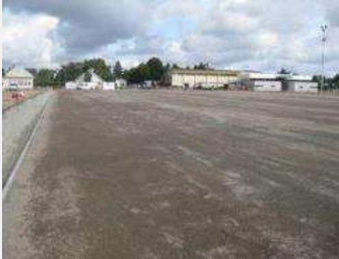
Réalisation du fin réglage de la plateforme et livraison des rouleaux de gazon synthétique
