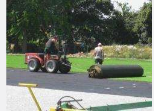
Déroulement mécanique du gazon synthétique
