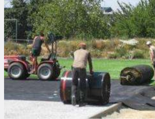
Déroulement mécanique du gazon synthétique
