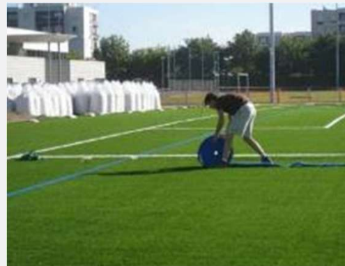
Découpage du revêtement synthétique et mise en collage des tracés
